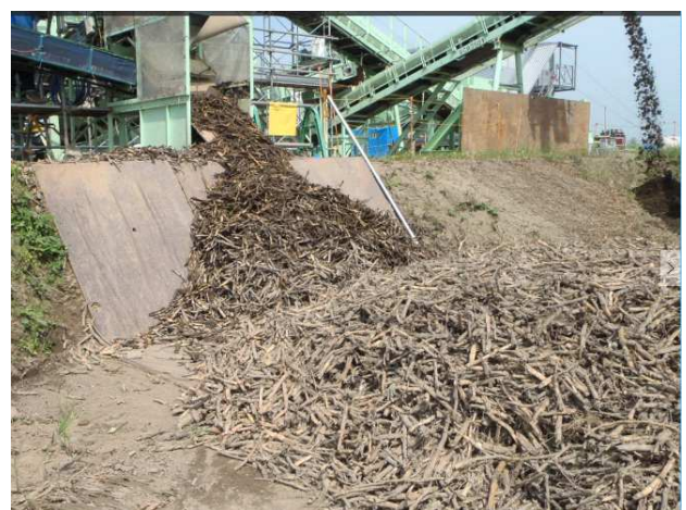
(改良事例) 粘性土改良 3万 m 3 除去した地下茎の容積 870m 3
