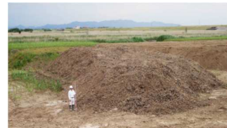
写真5 分別除去された葦地下茎 (870m³/30,000m³改良)
