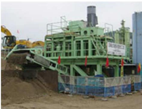
図-8 現場全景（軟岩破碎混合改良事例）
